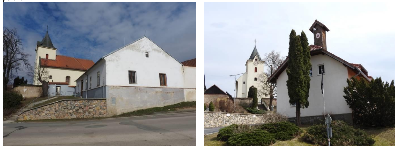
obr. č. C.2 a obr. č. C.3: Kostel sv. Jana Křtitele nad křižovatkou; na snímku vpravo objekt hasičské zbrojnice v nárožní poloze
