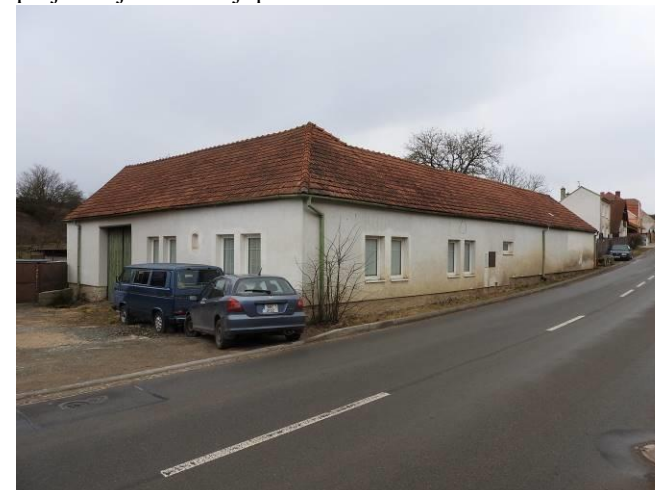
obr. č. C.10: Usedlost (dvůr) zachovalého měřítka a hmotového členění ve střední části sídla; celkově příznivý projev objektu snižují použitá okna.
