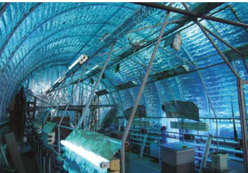
Obr. 1: Konstrukce proletové haly ve Výzkumném ústavu včelařském v Dole poodhalená při výměně vnitřního gázového tunelu.
